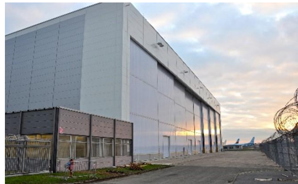
Bilder: Hangar Flughafen Hannover: Die Dachkonstruktion wurde um 5 m angehoben, Foto 1: flash.iFFect/Scheerschmidt, Foto 2: Flughafen Hannover
