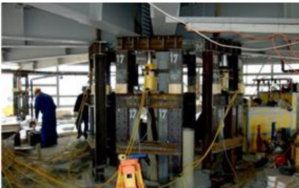
Bilder: UNIDO Gebäude C09 Wien: Die Geschoßhöhe wurde erhöht, Fotos: Zeman & Co
