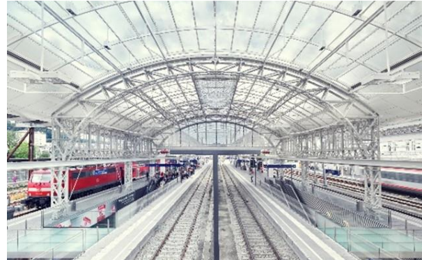
Bild 4 Hauptbahnhof Salzburg: Die historische Kassenhalle wird in die neuen Bahnsteigdächer integriert, Foto1: Zeman & Co., Foto 2: Taufik Kenan
