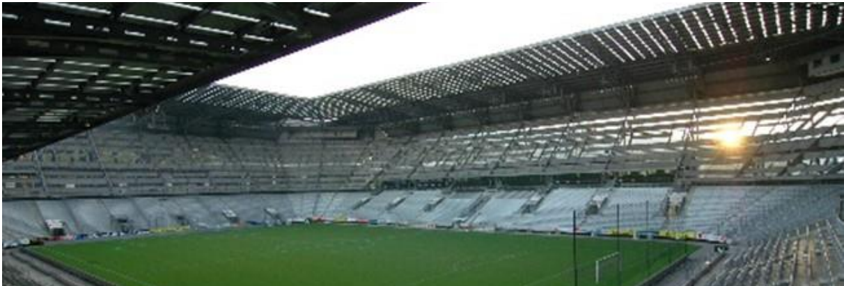
Bild: Tivoli Stadion Innsbruck. Temporäre Erweiterung der Tribünen, Foto: Thomas Praher
