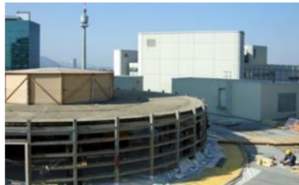
Bilder: UNIDO Gebäude C09 Wien: Die Geschoßhöhe wurde erhöht, Fotos: Zeman & Co
