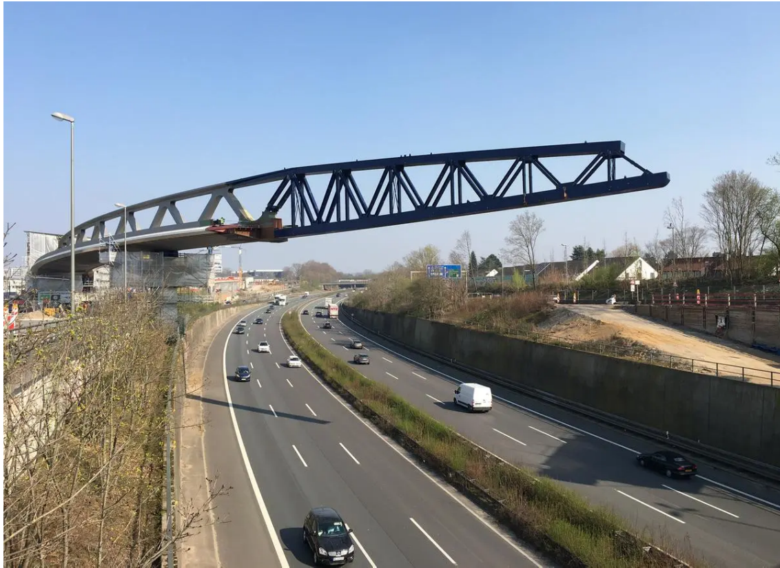
Kategorie Infrastruktur: U81 Stadtbahnbrücke über den Nordstern, Düsseldorf MCE GmbH
